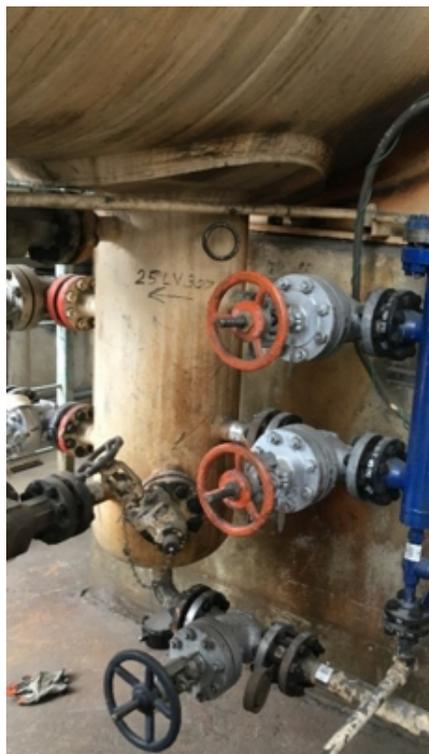
Figura 9: Bota para separação em refinaria (transmissor GWR instalado na câmara azul à direita)
