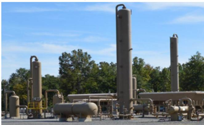
Figura 1: Vários tipos de separadores a montante
