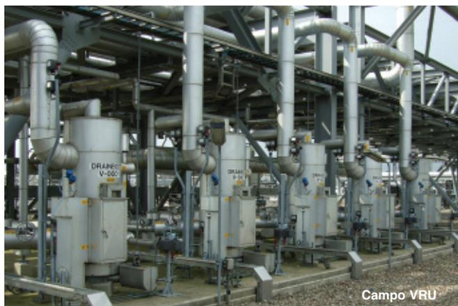
**Aplicação:** Uma Unidade de Recuperação de Vapor (VRU) captura compostos orgânicos voláteis e valiosos e outras correntes ricas em gás que podem vir ser um poluente ambiental significante. Uma VRU coleta de armazenamentos e instalações de carga, reliquifica os vapores, e retorna os hidrocarbonetos líquidos de volta ao armazenamento. Os métodos para recuperar vapor incluem absorção, condensação, adsorção e resfriamento simples.
