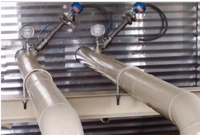
**Aplicação:** Da cabeça do poço à estação de compressão, monitorar o fluxo de gás natural é essencial. Outras aplicações de monitoramento de fluxo encontradas em configurações de gás natural podem incluir fluxo de ar comprimido e em massa, fluxo de gás residual (muito pedido para relatório de emissões ambientais) e processo, e proteção da bomba proporcionada pela detecção de condições de fluxo reduzido ou nulo.
