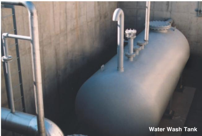
**Aplicação:** Água produzida, água de lavagem ou água de chuva coletada requer tratamento tanto para uso em inundação do reservatório quanto para descarte. Água coletada de operações de processo contém concentrações de hidrocarboneto altas demais para descarga com segurança. Gotículas de hidrocarboneto suspensas na água também impedem boa injeção.
