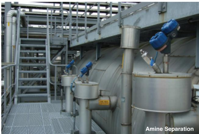
**Aplicação:** Especificações do gasoduto requerem remoção dos gases ácidos nocivos dióxido de carbono ( $CO_2$ ) e sulfato de hidrogênio ( $H_2S$ ).  $H_2S$  é altamente tóxico e corrosivo para aços de carbono.  $CO_2$  também é corrosivo e reduz o valor BTU do gás natural. Os processos de edulcoração do gás removem esses gases ácidos e geram gás natural comercializável e adequado para distribuição em gasoduto.
