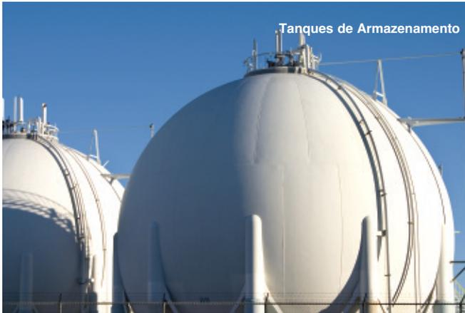
**Aplicação:** Gás natural, óleo, combustível líquido, químicos de tratamento, o condensado extraído de separadores e água são armazenados em campos de gás. Diferente das fazendas de tanques medianos em terminais e refinarias, o armazenamento de campo consiste em recipientes menores. Combustível de gerador de diesel, água potável, e água de fogo também são armazenados em tanques.
