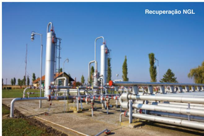
**Aplicação:** Separar os hidrocarbonetos e fluidos do gás natural puro produz gás natural seco de qualidade para gasoduto. As duas principais técnicas para remover Líquidos de Gás Natural (NGLs) são o método de absorção e expensor criogênico. O método de absorção é muito similar ao de desidratação, exceto pelo óleo absorvente ser usado no lugar do glicol. Quando os NGLs forem removidos da corrente de gás natural, devem ser separados ou fracionados.
