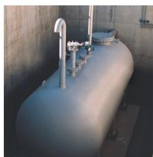
Instrumentação de nível para monitoramento do armazenamento químico deve resistir ao ataque de substâncias, se manter desafetado por mudanças no espaço de vapor e fornecer visibilidade e verificação de desempenho durante transferência de produto.
